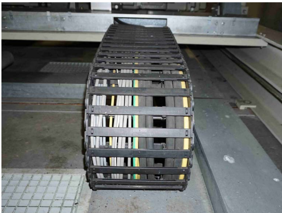
Obr. 5-4 Ukázka pohyblivého připojení kabeláže mezi skříňovými rozvaděči a DC pohony či rozvaděči měření
