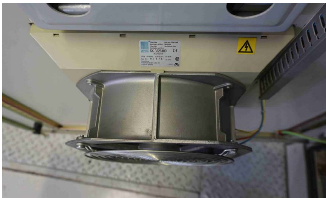
Obr. 5-2 Ventilační jednotka skříňového rozvaděče
